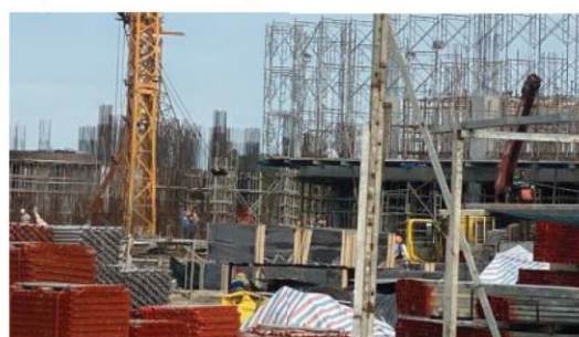
Dự án: Trường ĐH Y Khoa Phạm Ngọc Thạch cơ sở 2 – Bình Chánh – TP. HCM
